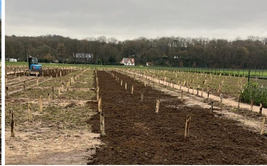
Egaliseren na aanleg paden
